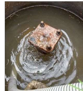
空気弁からの漏水と職員による補修作業の様子 (6月1日)
