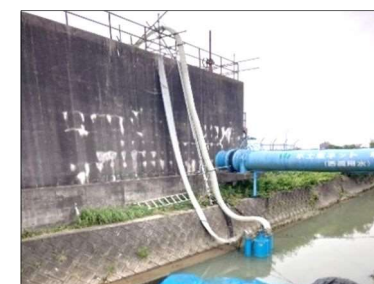
ポンプ設置状況 (6月2日) (安城市内、排水路)
