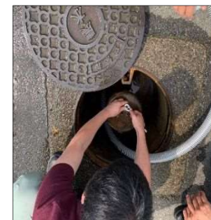
空気弁からの漏水と職員による補修作業の様子 (6月1日)
