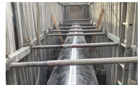
管路布設状況
