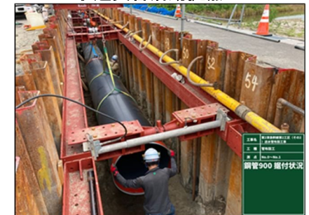
水道管路の布設状況
