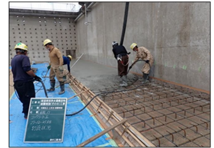
浄水場（沈澱池）耐震補強状況
