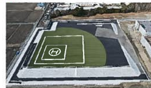
▲旧永和荘跡地整備状況
